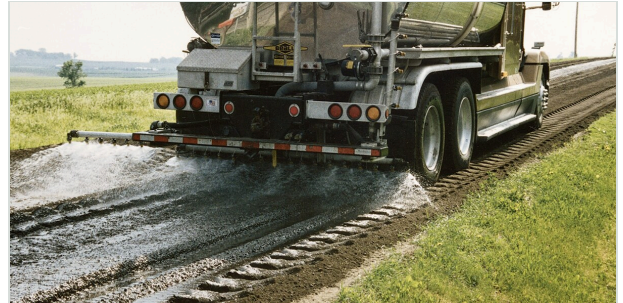
Camion-citerne distributeur à rampe de pulvérisation calibrée.
